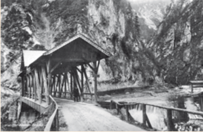
Die erst am 2. Dezember 1914 fertig gestellte, große gezimmerte Holzbrücke am Eingang der Straße in Kundl. Sie steht heute unter Denkmalschutz.
