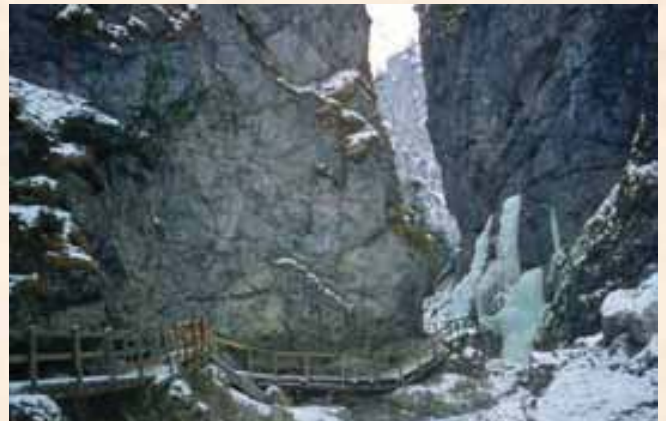
Immer wieder zerstörten Unwetter größere Teile der Straße. Man behelft sich mit provisorischen Instandsetzungen.
