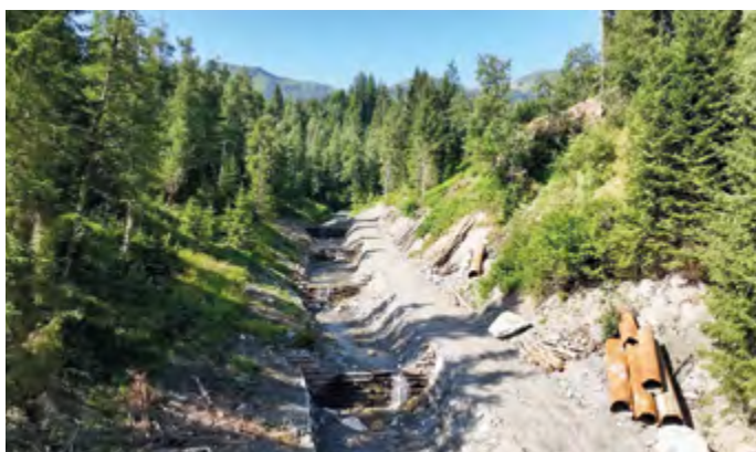
Im Mittellauf des Holzergrabens – oberhalb der Geschiebesperre – werden bestehende Holzsperrren saniert und weitere ergänzt. © Toni Silberberger
