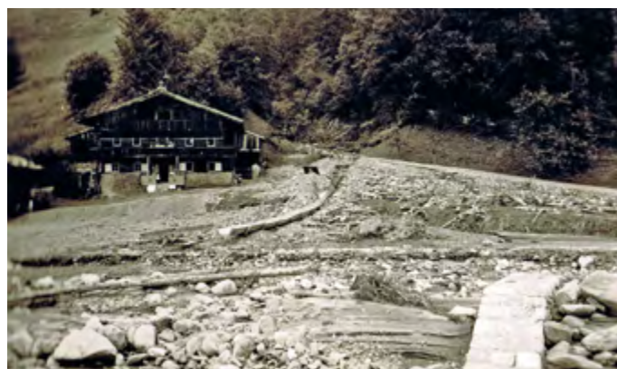
Auf der Aufnahme sieht man den Hof „Unterrain“ (vgl. „Schinter“). Seitlich kam das Hochwasser vom Riedgraben, vorne grub sich die Wildschönauer Ache bis direkt vor das Bauernhaus.
