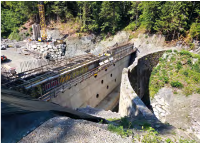
Das zentrale Bauwerk im Holzergraben ist die Geschiebesperre: Vor der alten Mauer aus dem Jahr 1966 wird zusätzlich eine neue Mauer errichtet. © Toni Silberberger
