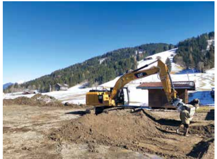
Baustart Freizeitpark Wildschönau
