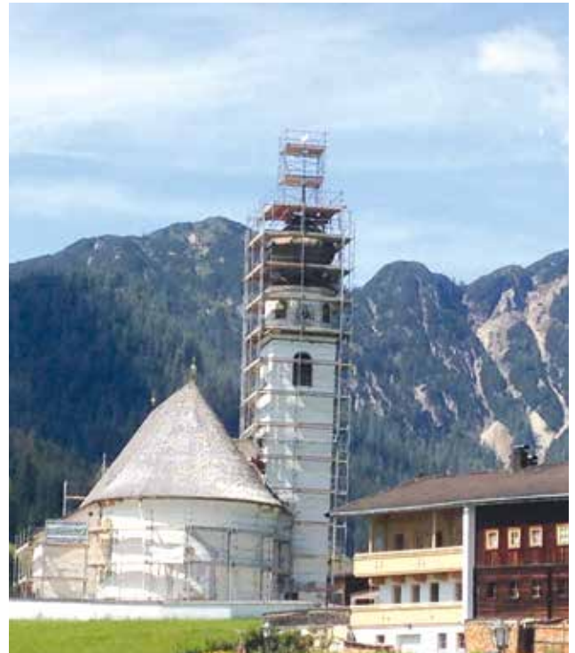
Die Renovierungsarbeiten an der Pfarrkirche Thierbach sind voll im Gang
