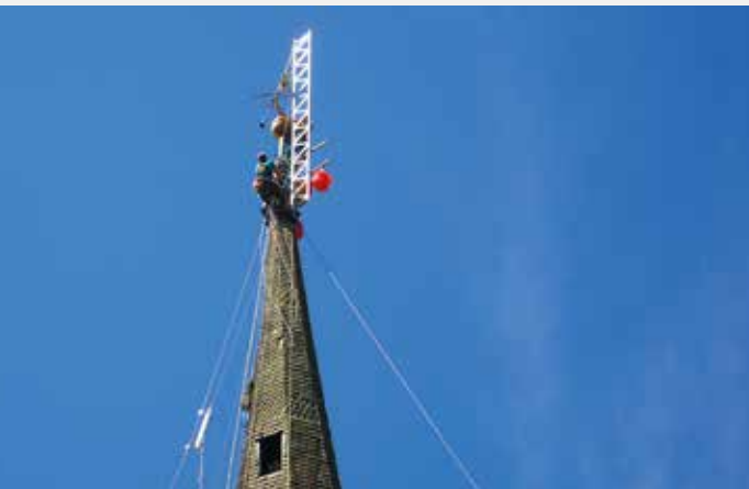
Abnehmen des Turmkreuzes zu Beginn der Kirchturmrenovierung durch Martin Berger
